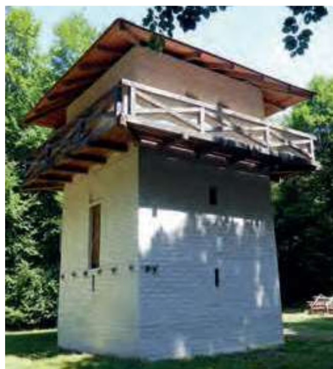
Limes-Wachtturm in Limeshain: Der mit antiken Bautechniken und authentischen Baustoffen rekonstruierte römische Wachtturm 3
