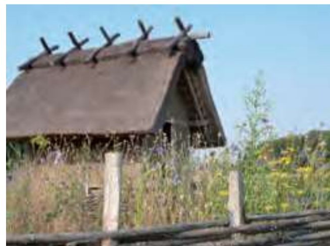
Der rekonstruierte Getreidespeicher ist mit Reet gedeckt und besteht aus Eichenpfosten mit lehmverputzten Flechtwerkwänden
