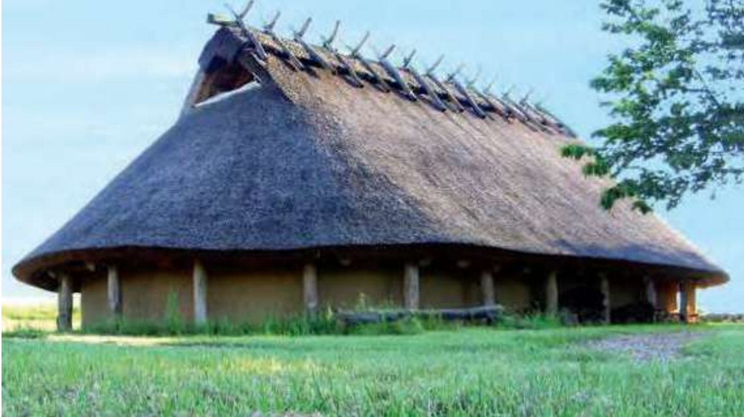
Rekonstruktion eines Wohnstallhauses: zweischiffige Hausform (Eisenzeithaus)
