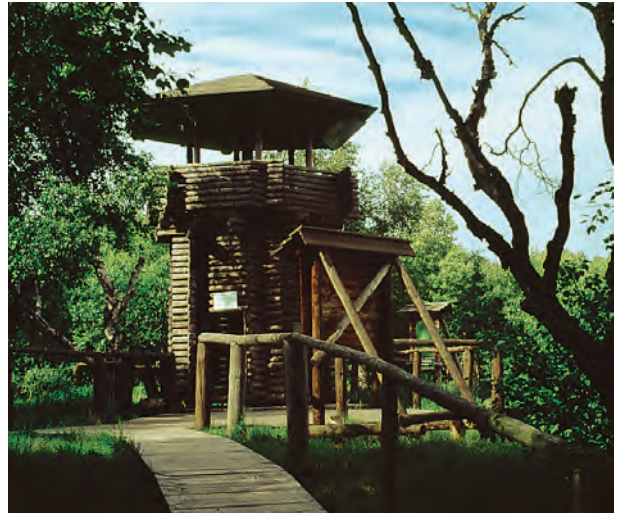
Der Aussichtsturm im Roten Moor gestattet einen informativen Blick auf das noch intakte sowie das völlig abgetorfte Gebiet des Moores.
