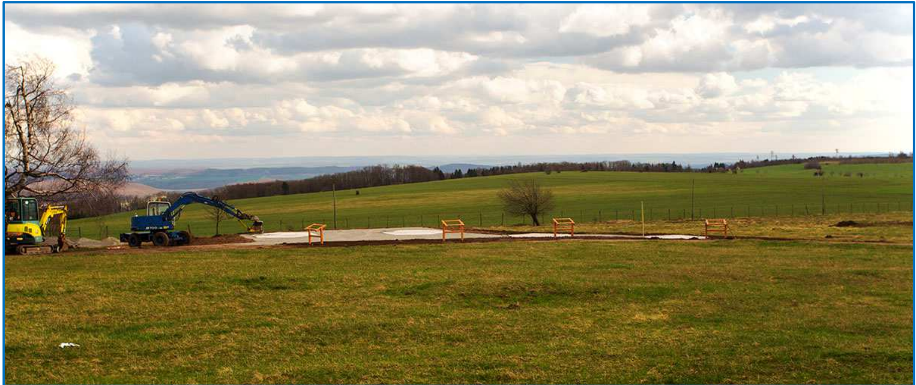
Abb.2 Die 4 Plattformen im Bau, Blickrichtung nach Südost
