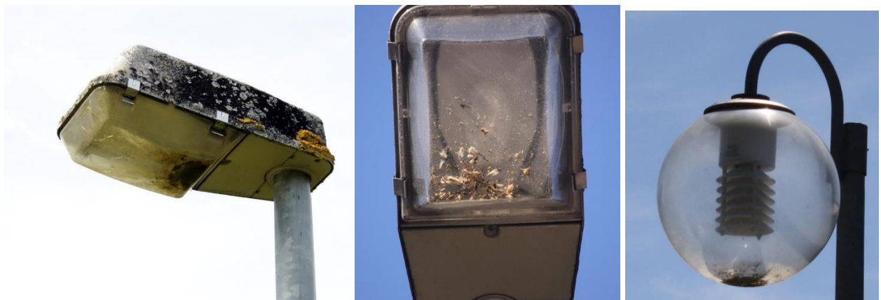
In undichten Leuchtengehäuse können Insekten eindringen und kommen darin um, da sie es nicht wieder verlassen können.
