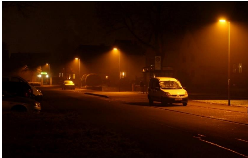
Ausleuchtung einer Straße mit niedrigen Masthöhen und bernsteinfarbenen LED-Leuchten
